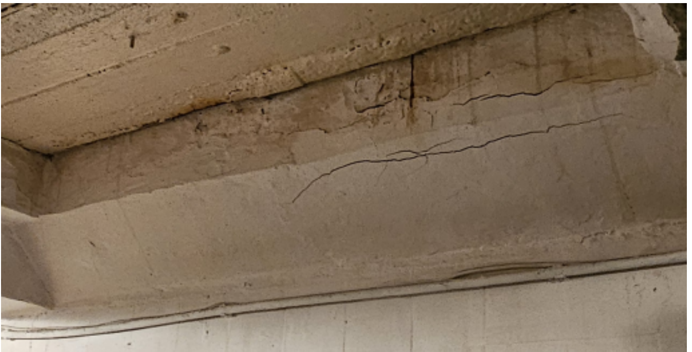
Fotografia numer 9. Widok na miejsce numer 3 z widocznym przeciekiem i korozją zbrojenia.
