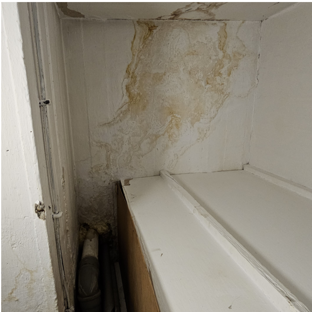
Fotografia numer 15. Widok na spód stropu z przeciekiem.
