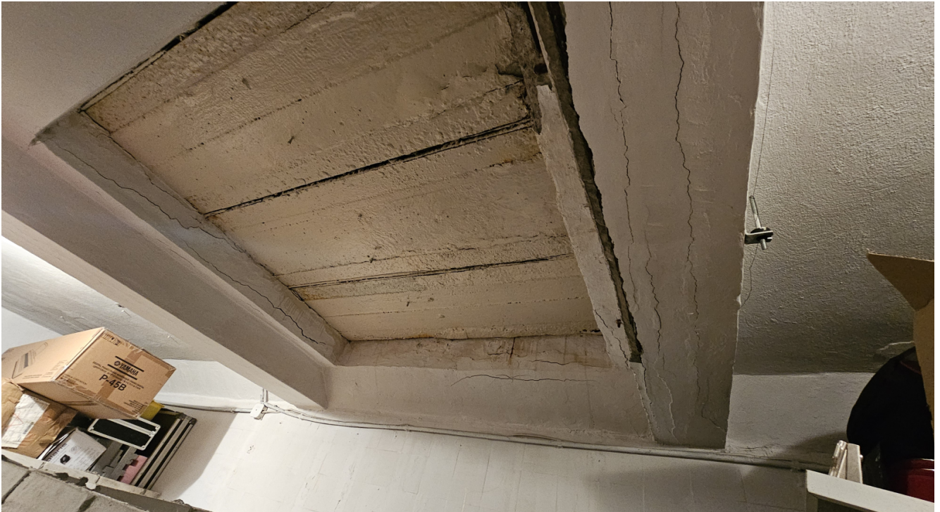
Fotografia numer 5. Widok na żebra i płyty stropowe włączu.
