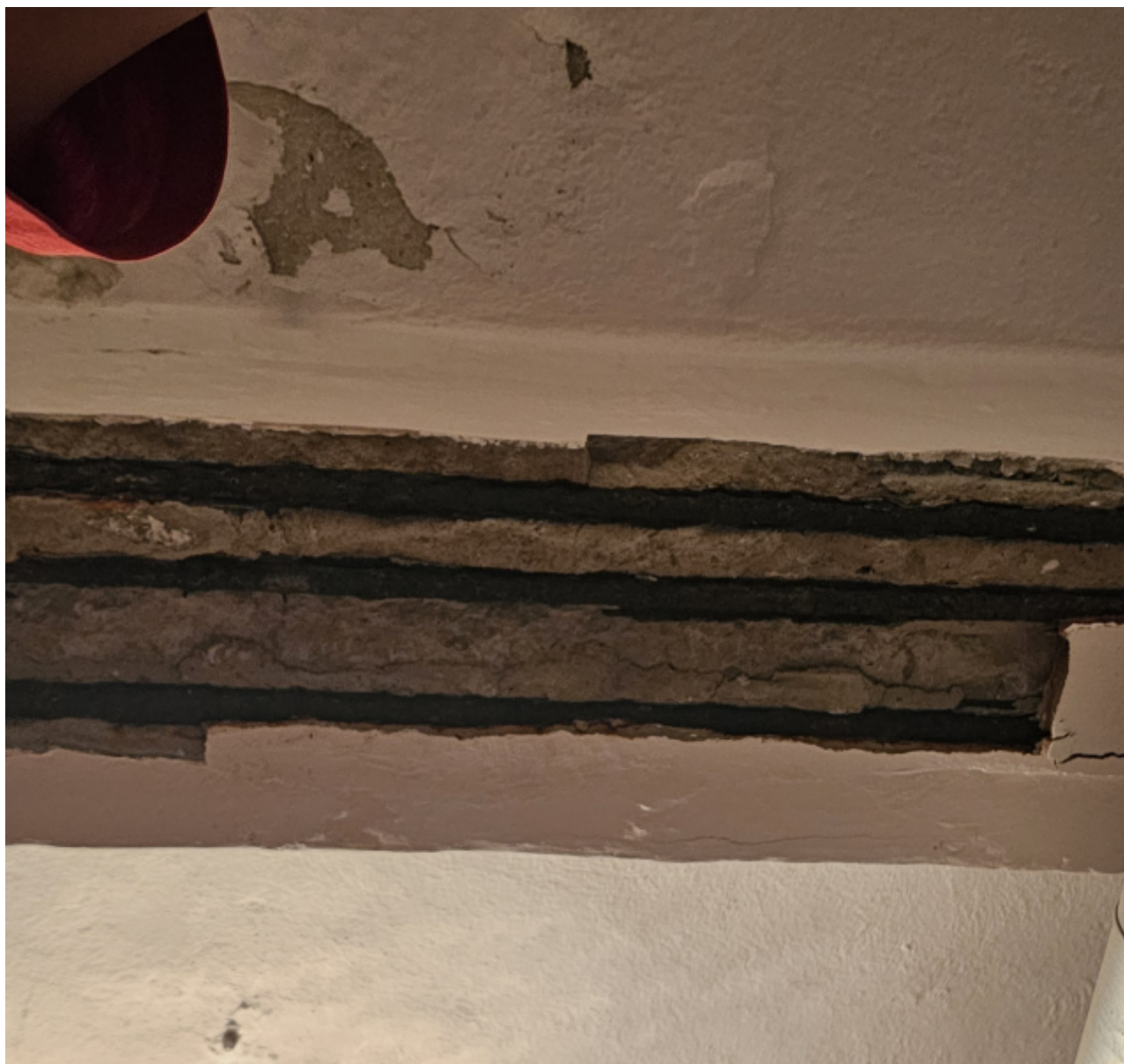
Fotografia numer 7. Widok na 3 z 4 sztuk prętów głównych dolnych żebra przy wjeździe.
