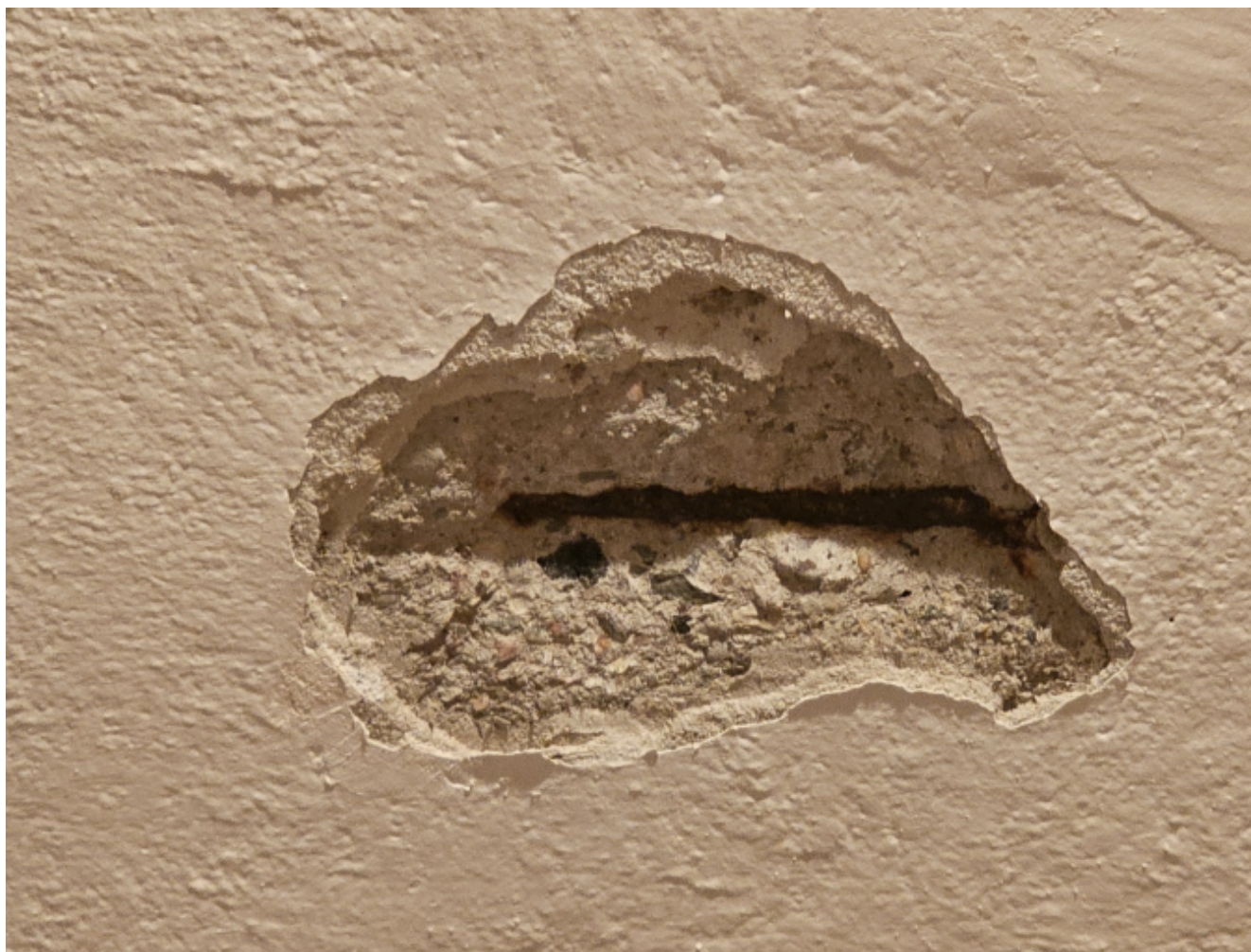
Fotografia numer 10. Widok na miejsce numer 7 z widoczną zaawansowaną korozją zbrojenia.
