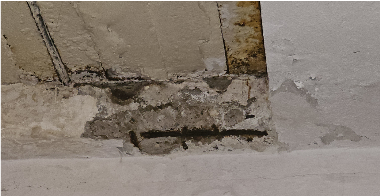
Fotografia numer 8. Widok na miejsce numer 5 z widocznym przeciekiem i korozją zbrojenia.
